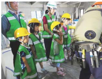
工事現場（結束作業）
