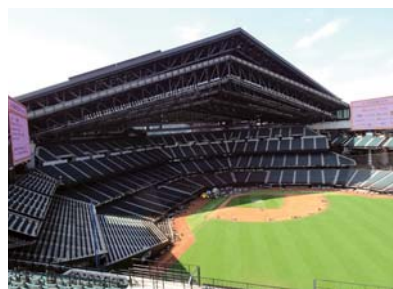
天井が開放されたエスコンフィールド
